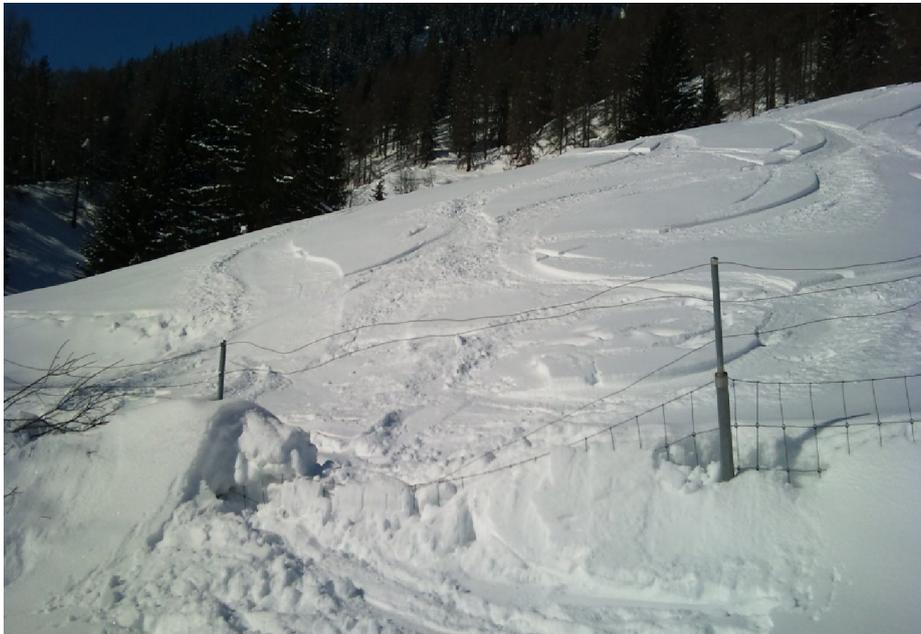
Oberhalb des Geheges haben sich im Dezember 2011 zahlreiche Schneebretter gelöst und sind mit voller Wucht in den Zaun gerast. Durch den Schneedruck und die Verwehungen sind am gesamten Gehege viele Eisenstangen verbogen, und die Schäden am Drahtzaun sind gewaltig. Der Druck wird durch den Nassschnee im Frühling noch zunehmen. Ein genaues Schadensbild kann wohl erst nach der Schneeschmelze gemacht werden.
