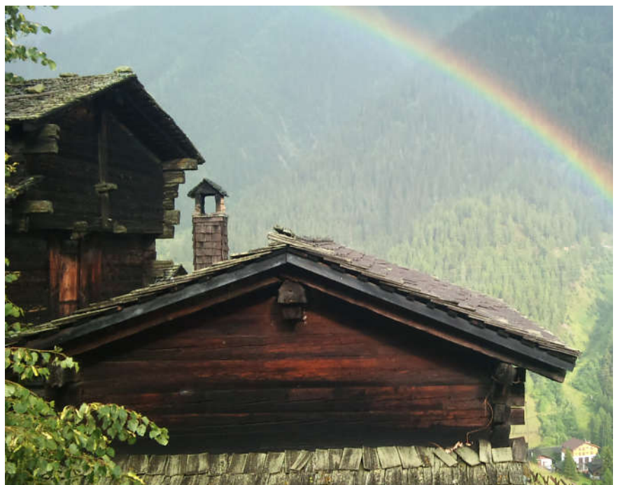
Kamin des Spycherli in unmittelbarer Nähe vom Nebengebäude
