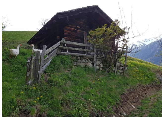
Alphütte vor der Sanierung
